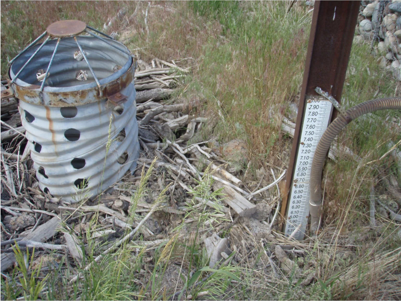
Photo 4 Los Alamos weir standpipe inlet
