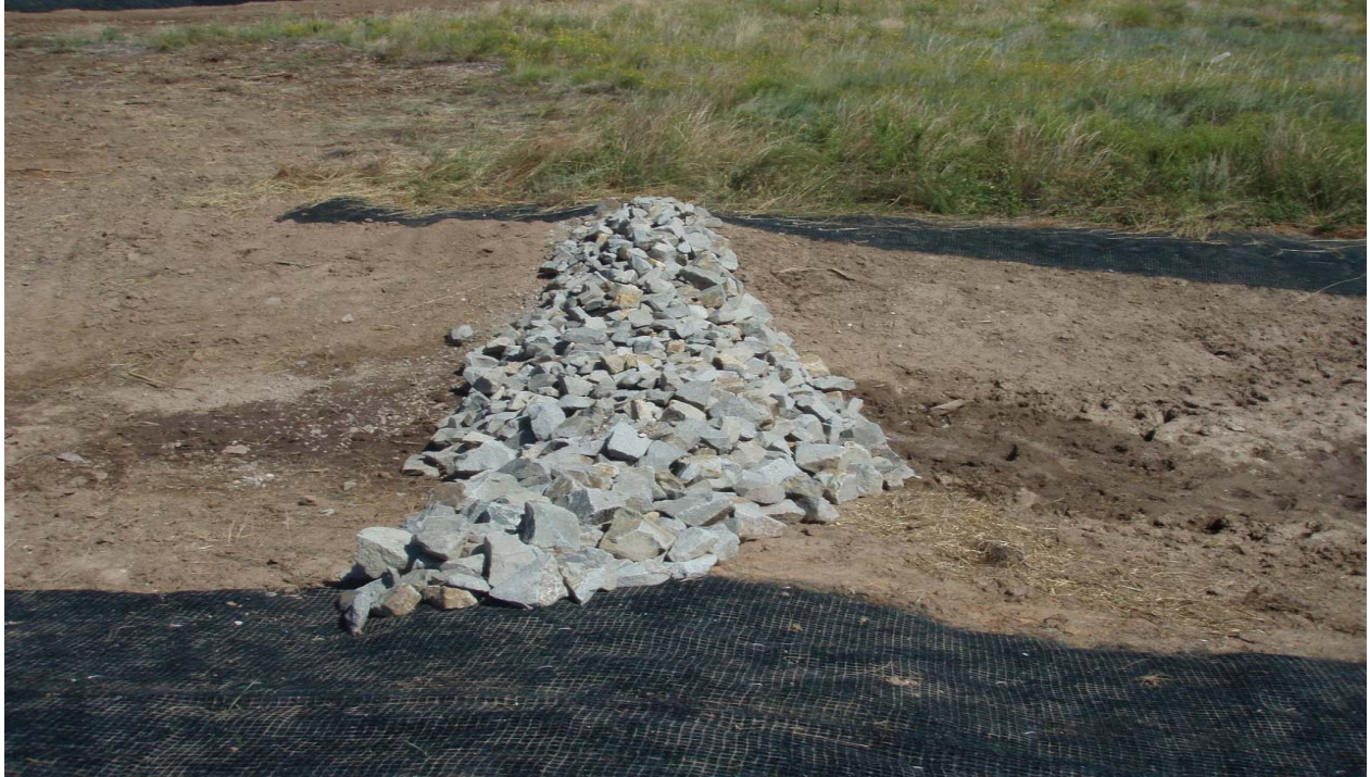
Photo: 49929-10.JPG F00103120021 Berms
