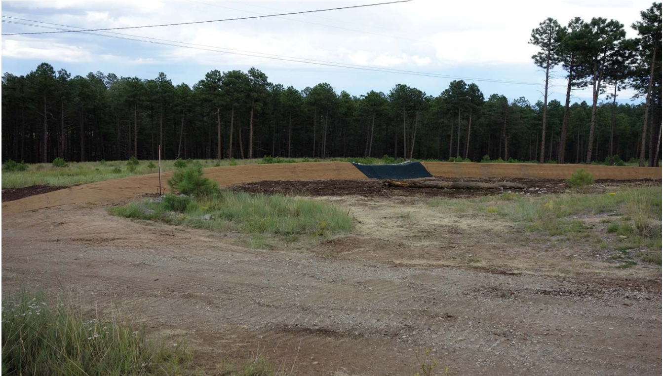
Photo: 49619-5.jpg J00103010022 Berms
