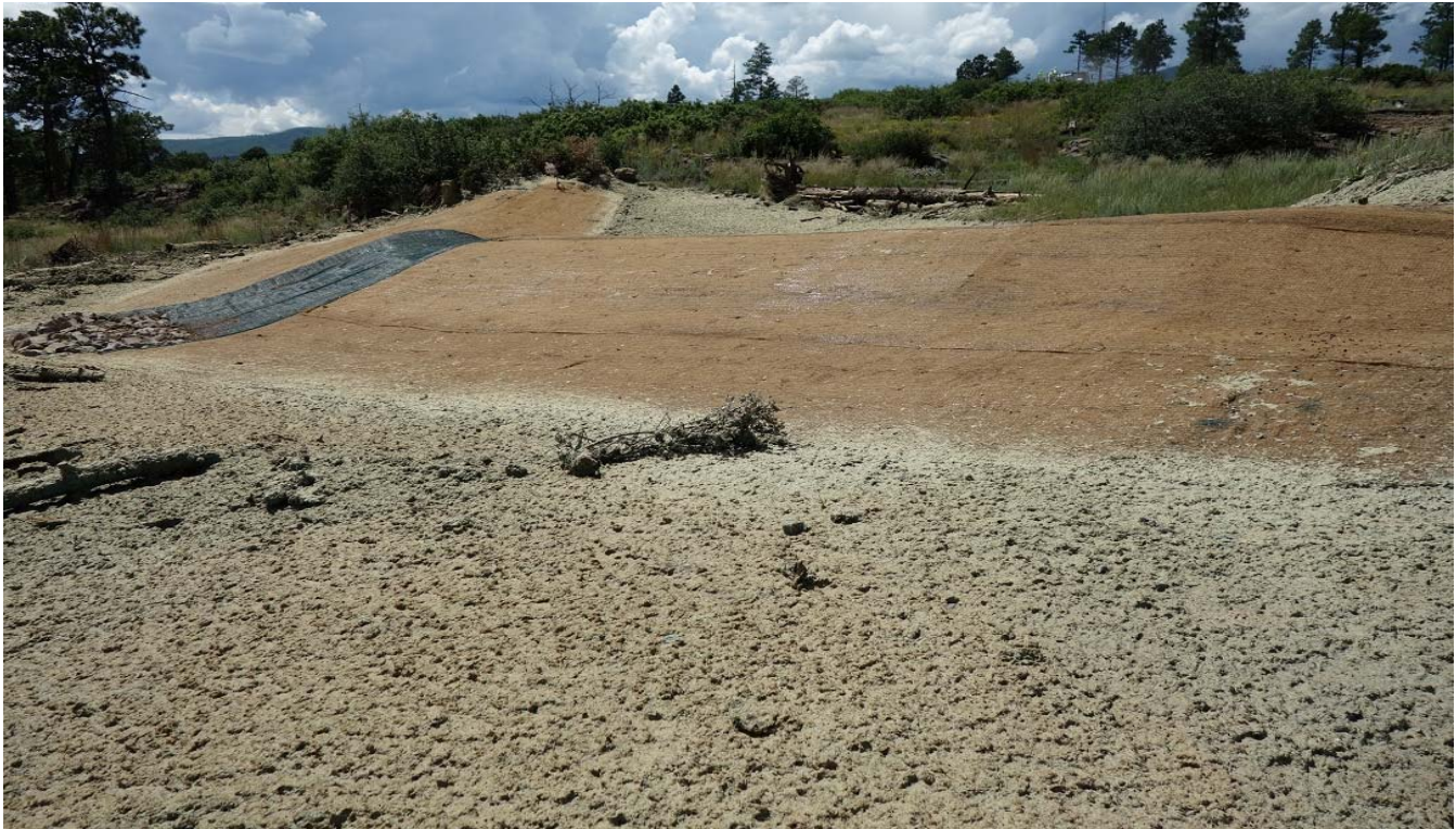
Photo: 49618-14.jpg E01403010029 Berms
