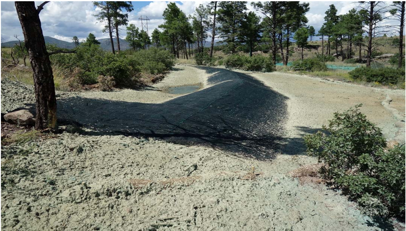
Photo: 49618-9.jpg E01403010028 Berms
