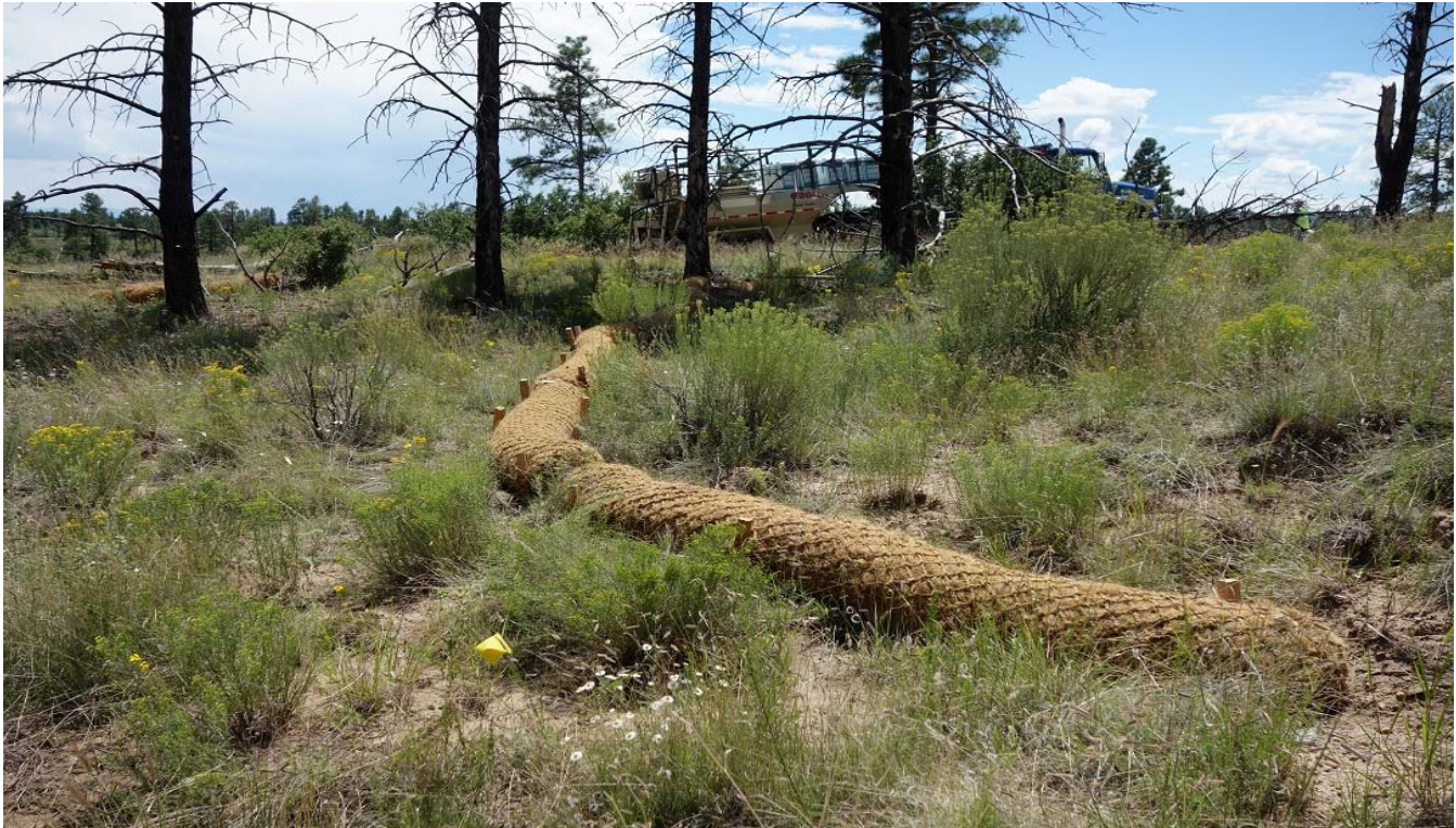
Photo: 49618-2.jpg E01403140023 Berms
